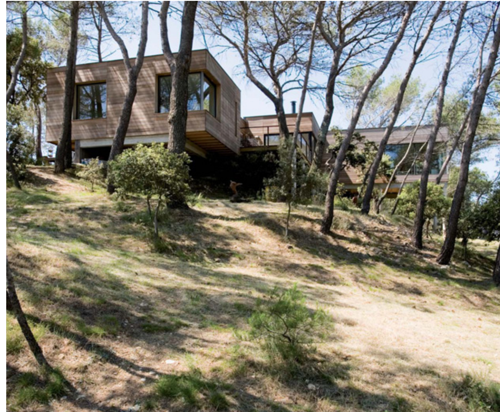
Façade nord. L'évolution du chantier sur la façade nord est particulièrement lisible au niveau du sas de l'entrée et de l'abri vélos. Le premier est identifié par des murets revêtus de bardage, tandis que des claustras définissent l'espace du second.
